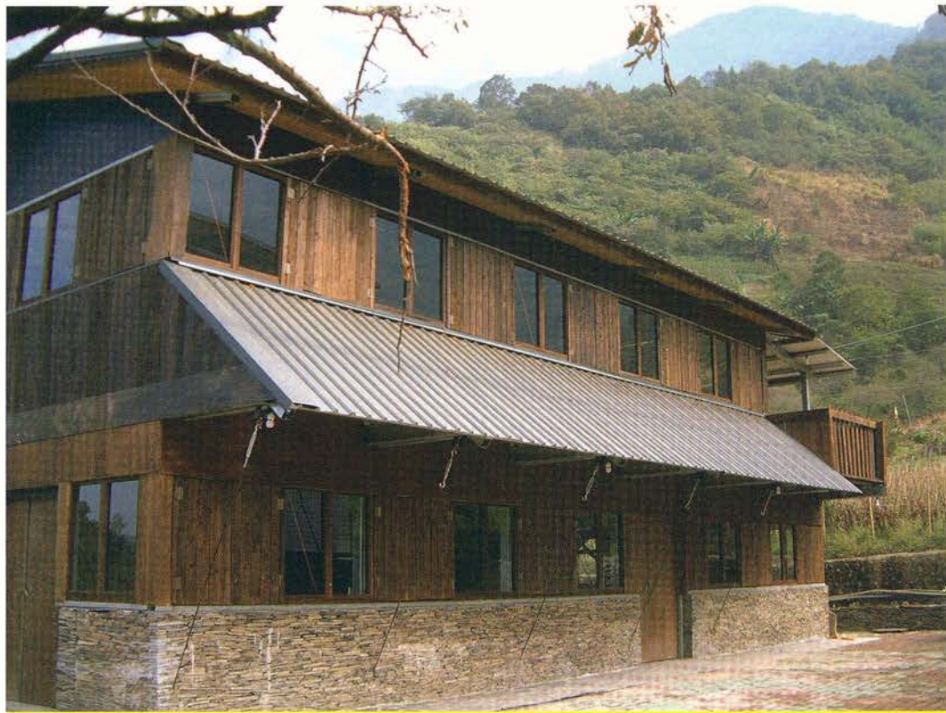
東埔部落教室：由部落居民協力建造完成的部落教室。地點：南投縣信義鄉東部部落。 材料：輕量型鋼、石材、杉木雨淋板
