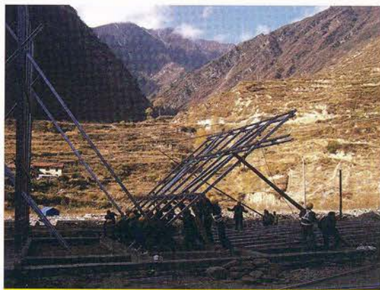
楊柳起架。四川省茂縣楊柳村的羌族人在 512 地震後需整村搬遷，他們接受了輕量型鋼的建房方式，並組織村民協力造屋。他們以傳統唱號子的方式把鋼架用人力組立起來
