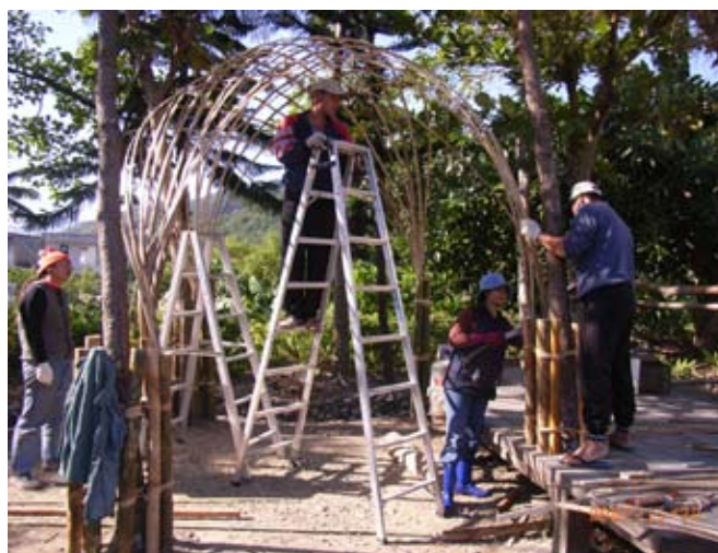
圖41（左上），在樹幹周圍幫樹木製作保護的竹管以便竹片的安插。 圖42（右上），設計規劃者和施作的夥伴現場討論竹片與竹管的交接方式。 圖43-45（下3張），竹片對角平織交編插入竹管，能夠產生拱狀而堅固的造型。
